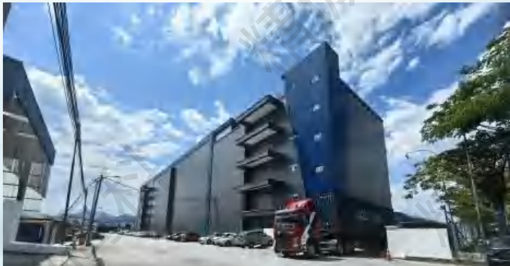
广东精诚高科建设有限公司马来西亚数据中心项目
