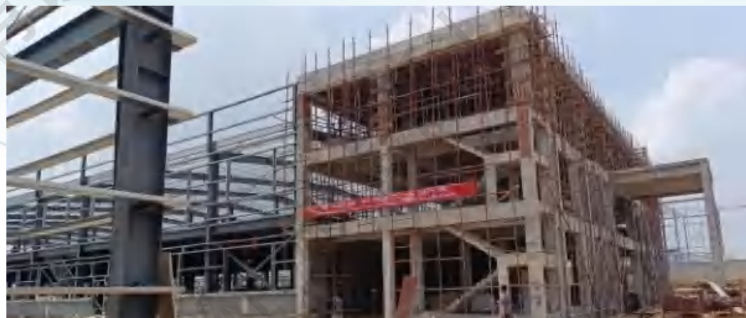
广东精诚高科建设有限公司国外项目
